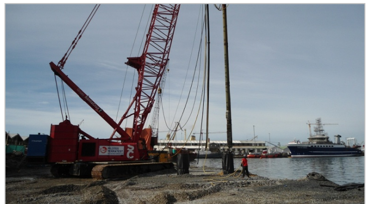
Fotos de Obra: Ejecución de Columnas de Grava Off-Shore
