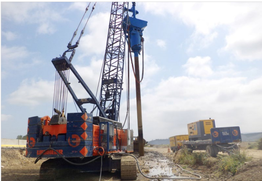
Foto 2 y 3: Ejecución de Columnas de Grava.
