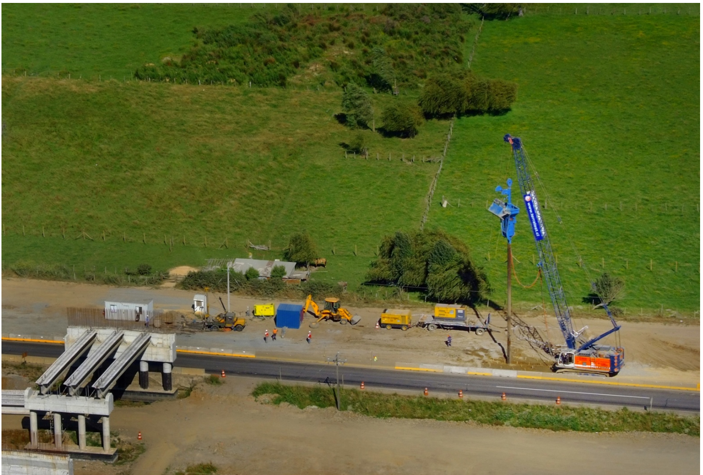
Foto 1: Foto Aérea de Ejecución de Columnas de Grava.
