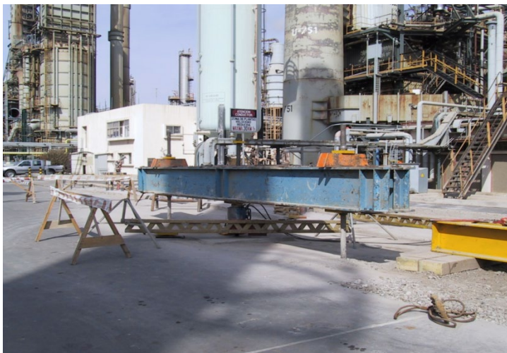
Foto 3 y 4: Detalle del montaje del ensayo a tracción efectuado.
