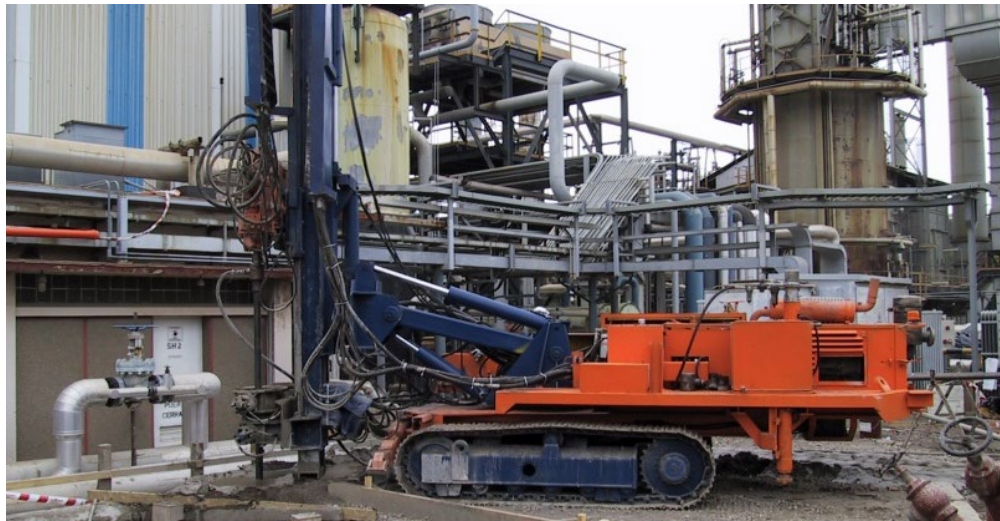
Foto 1: Ejecución de Micropilotes. Se aprecian las restricciones de espacio existentes.
