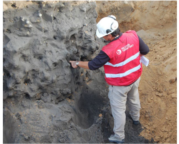
Imagen 2 – Campo de Prueba Excavado en Obra.
