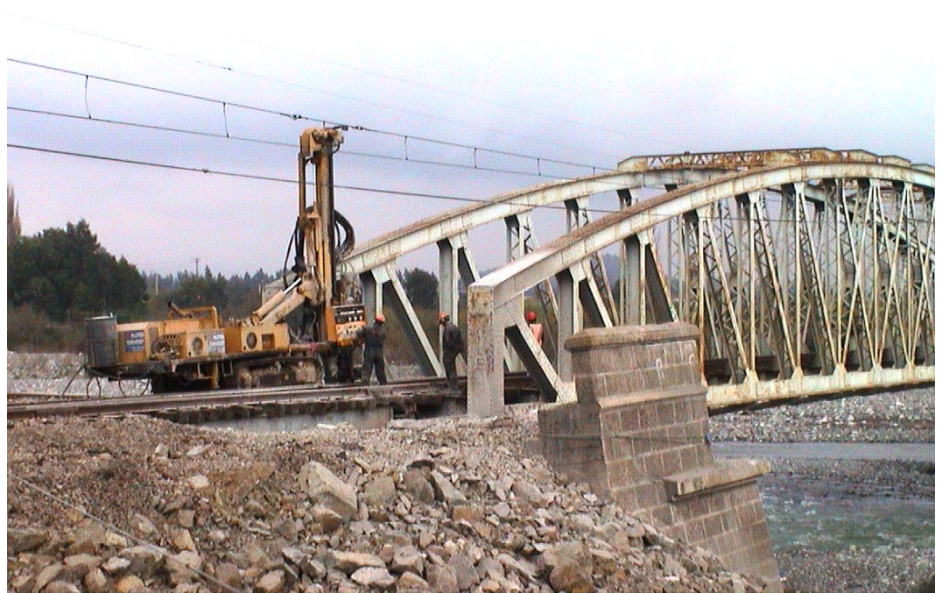
Foto 1 – Vista del puente.
