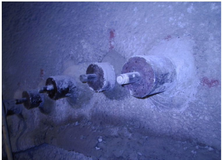
Foto 3 – Detalle paraguas entubados.
