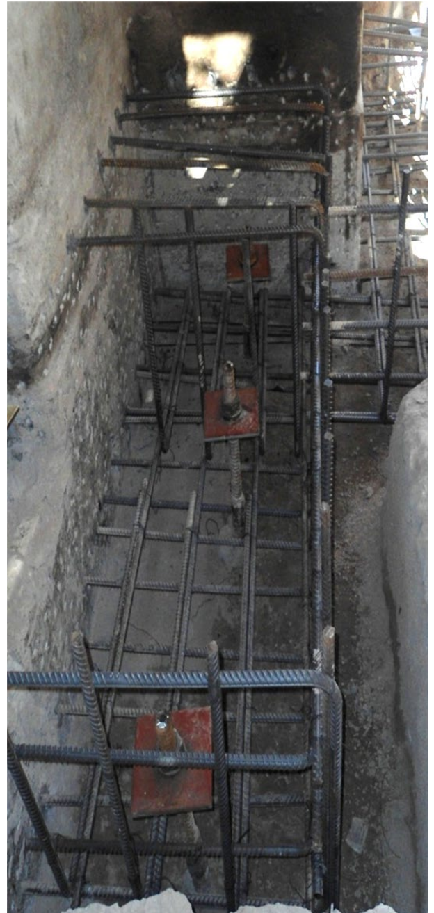
Imagen 4 – Micropilotes Ejecutados, ya con la armadura del dado de Fundación instalada, a la espera del hormigonado.
