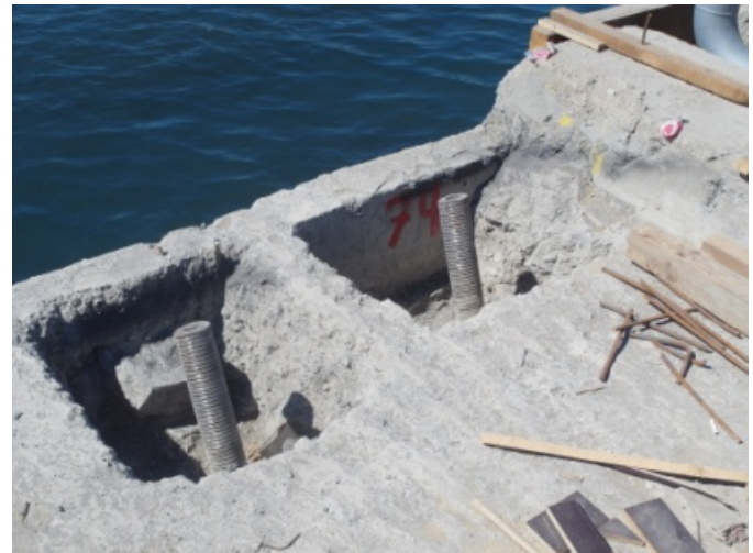
Imagen 2 - 3 – Detalle de Micropilotes Ischebeck TITAN 103/51 instalados.
