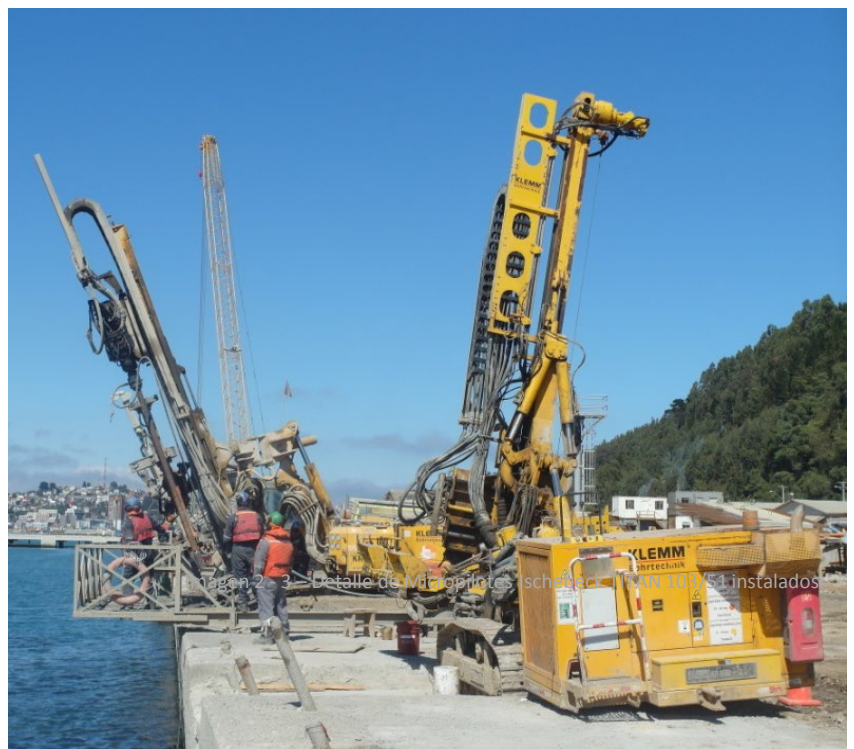
Imagen 4 – Ejecución de los trabajos.
