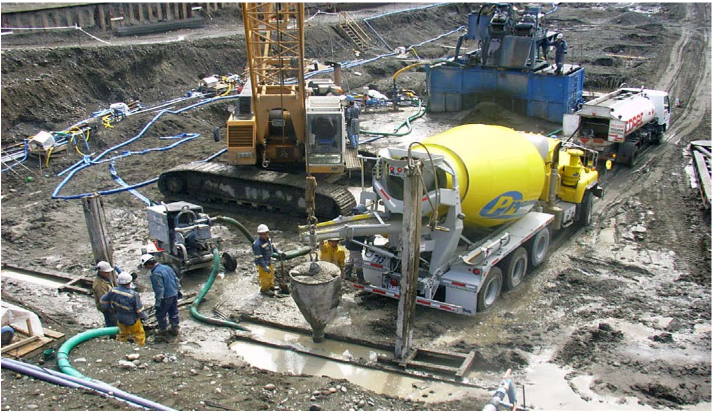
Foto 1 – Foto Panorámica del hormigonado de la Pantalla
