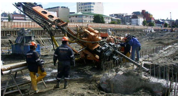
Foto 3 – Ejecución de Anclajes en la Pantalla
