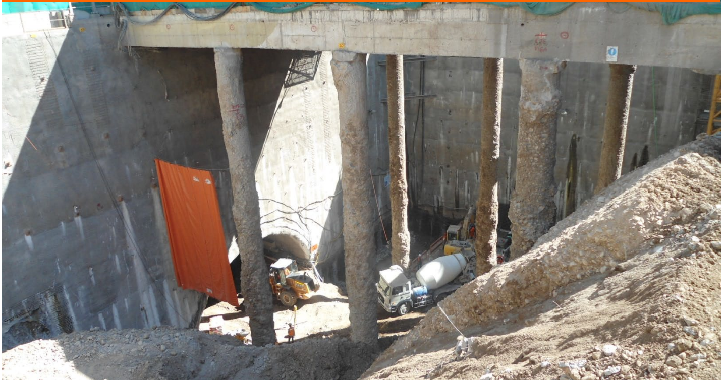
Foto 1 - Vistas de la Obra Estación Los Leones - Norte.
