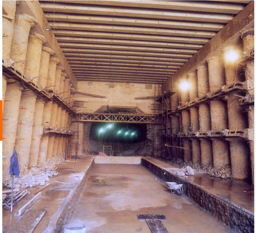
Foto 1 - Vista de la Obra.
