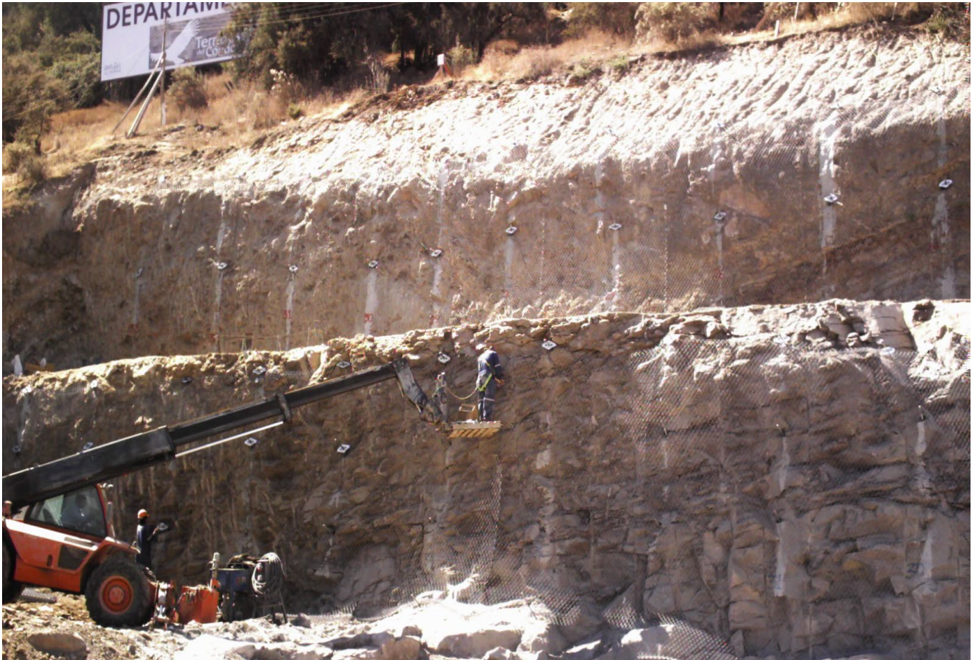
Vista General del Talud.
