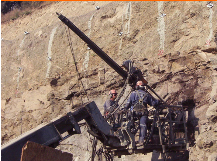
Instalación de los Anclajes Pasivos o Nails.
