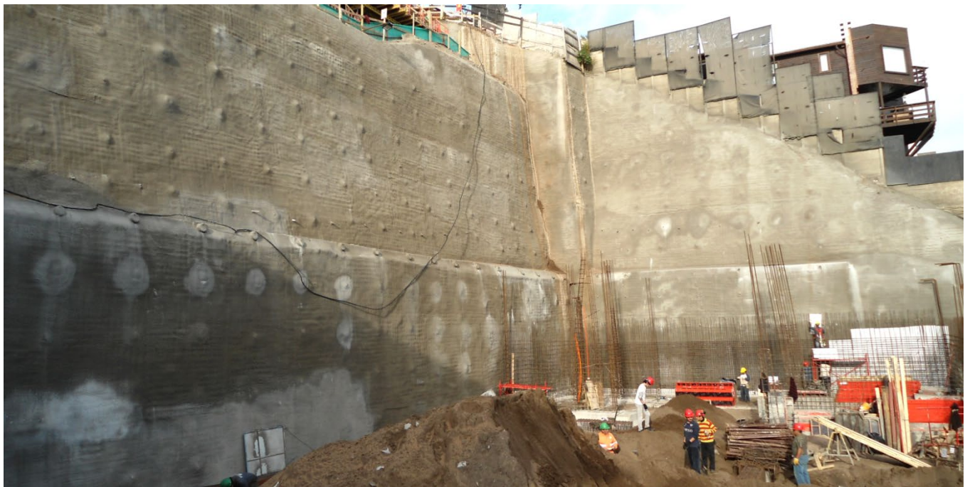
Panorámica de muros de contención tipo Soil Nailing.
