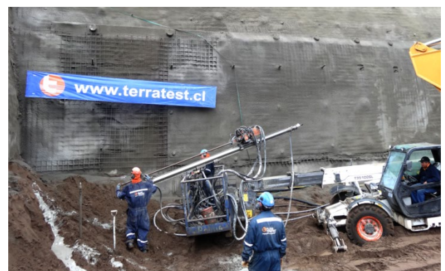
Soil Nailing en proceso de ejecución.
