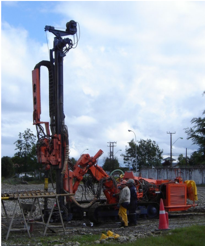
Foto 4 – Sondajes Explanta de abastecimientos de Combustibles – Puerto Montt
