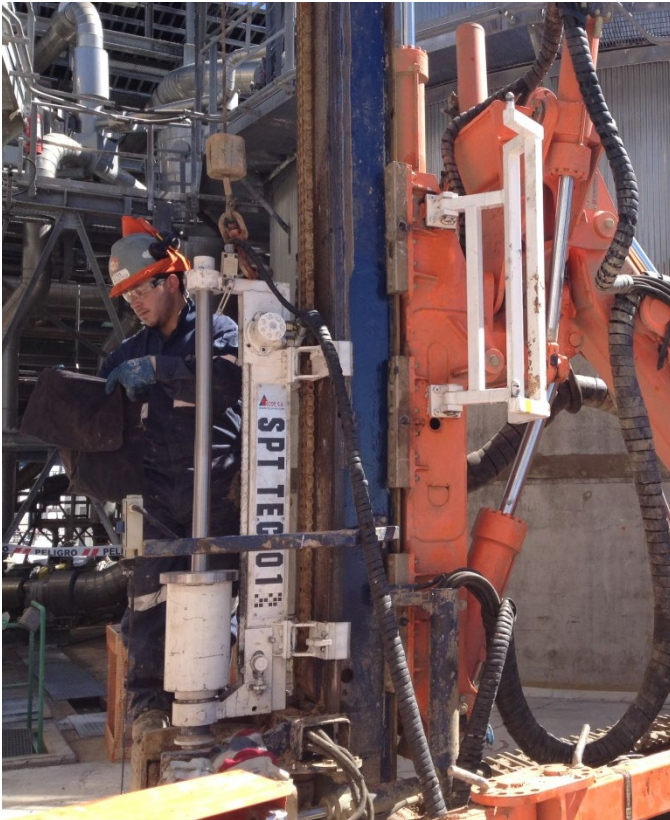
Imagen 7 – Ejecución de ensayo geotécnicos SPT.
