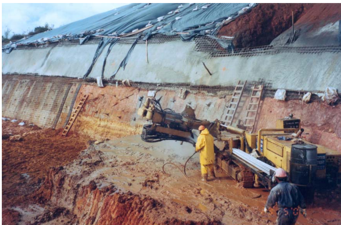
Figura 6. Etapa de ejecución del muro en forma descendente.
