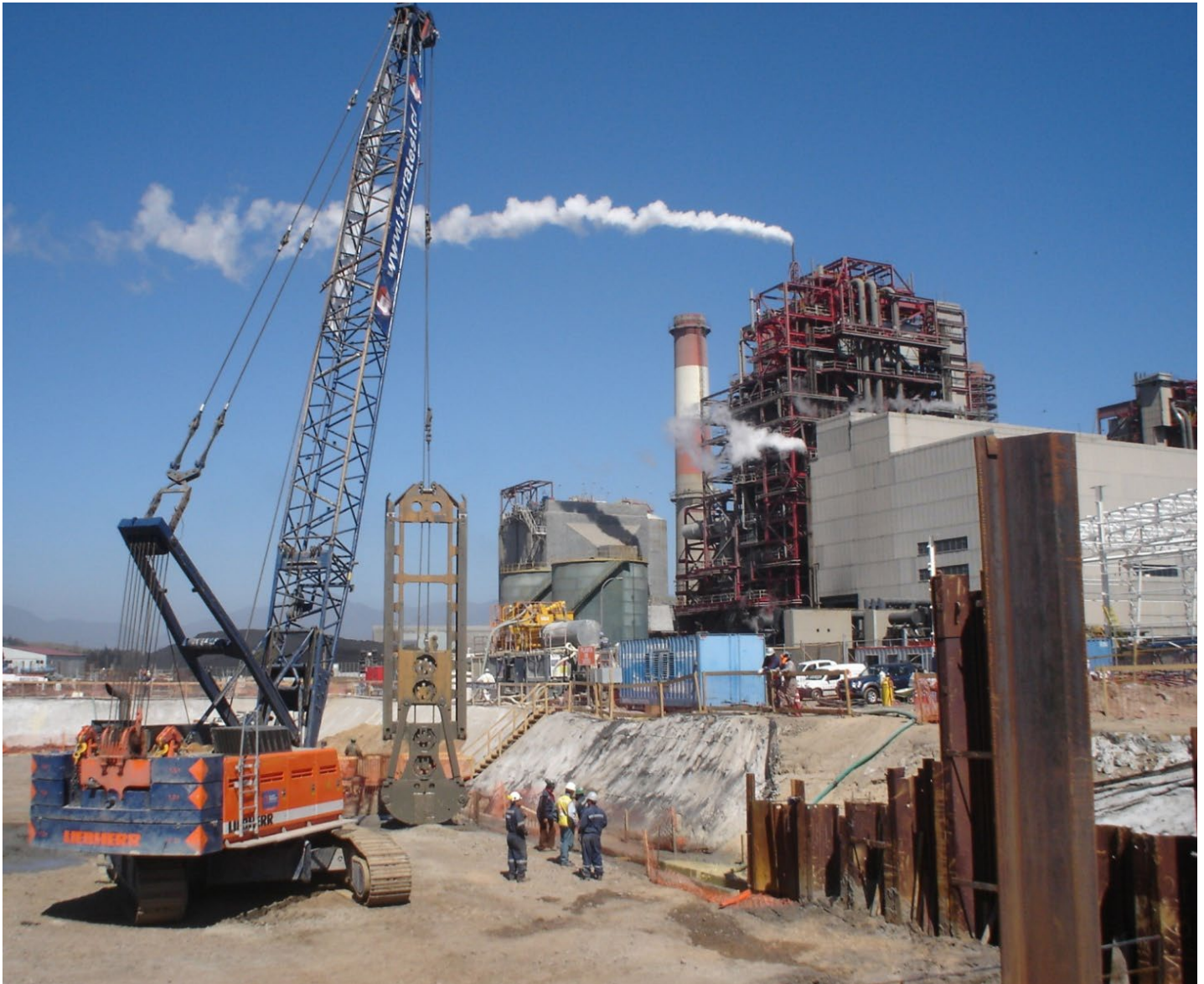
Imagen 2 – Excavación de Pantalla mediante Cuchara Mecánica y tablestacas instaladas.
