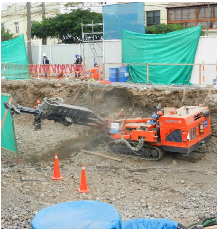
Zona a estabilizar a la llegada de los equipos de perforación.
