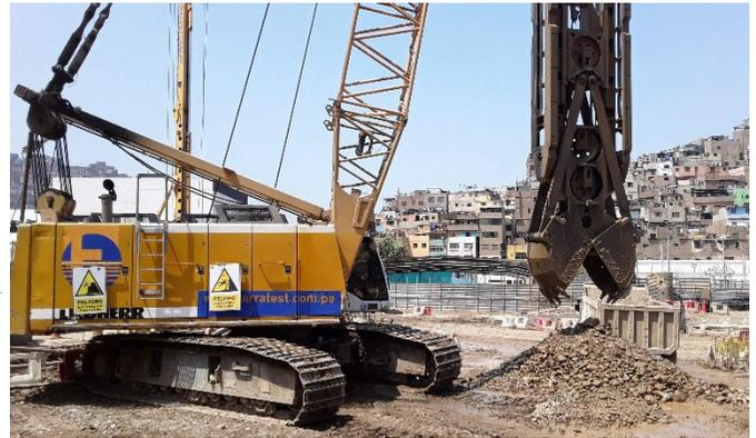
Fig.11: Excavación de pantalla con herramienta convencional.
