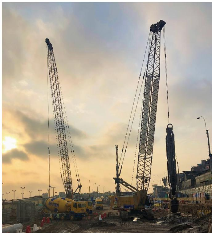
Fig.6: Excavación y vaciado de pantalla en la Estación 17 “Nicolás Ayllón”
