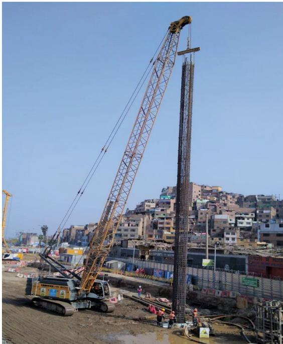
Fig.16: Colocación de armadura en perforación.
