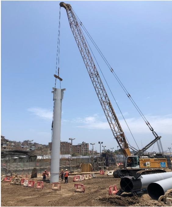
Fig.14: Colocación de camisa metálica en perforación.
