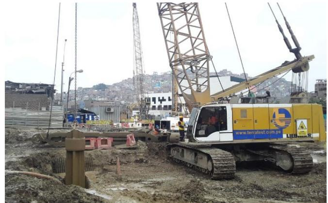
Fig.12: Uso de herramienta especial para material rocoso (Trépano)
