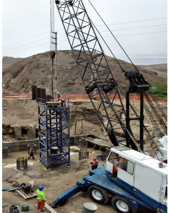
Figura 07. Prueba de Carga Dinámica.
