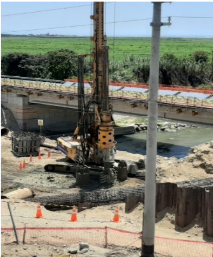
Figura 02. Ejecución de pilotes excavados
