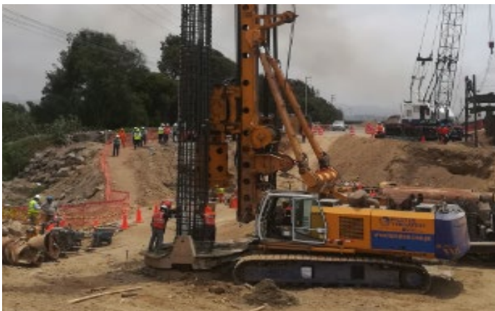
Figura 05. Colocación de armadura.
