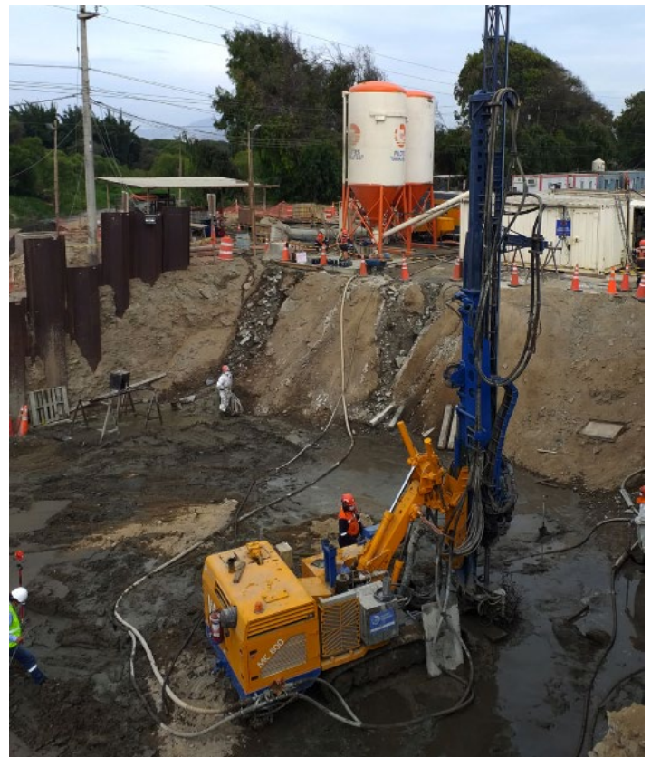
Figura 03. Ejecución de recalce con columnas de Jet Grouting
