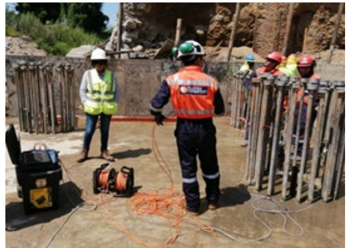
Figura 08. Prueba de Integridad tipo Cross Hole.
